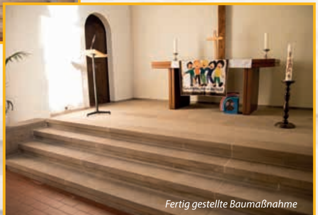
Vor der Sanierung unterschiedliche Stufen
